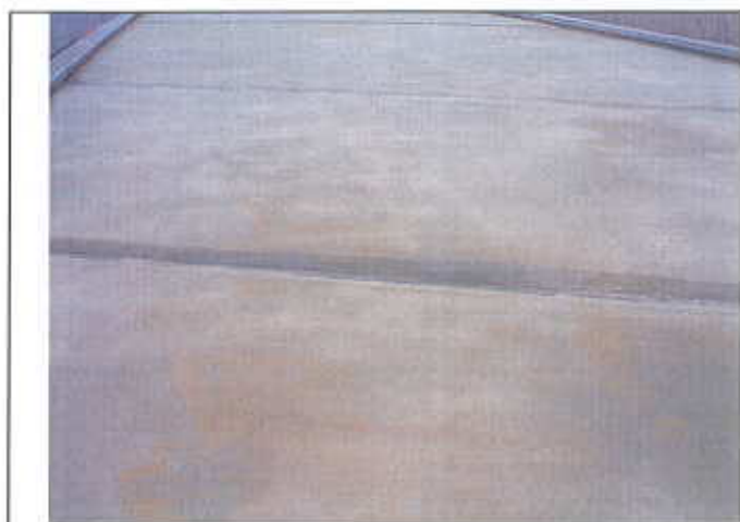
Cliché 1 : Vue générale du revêtement en résine recouvrant l'ouvrage
